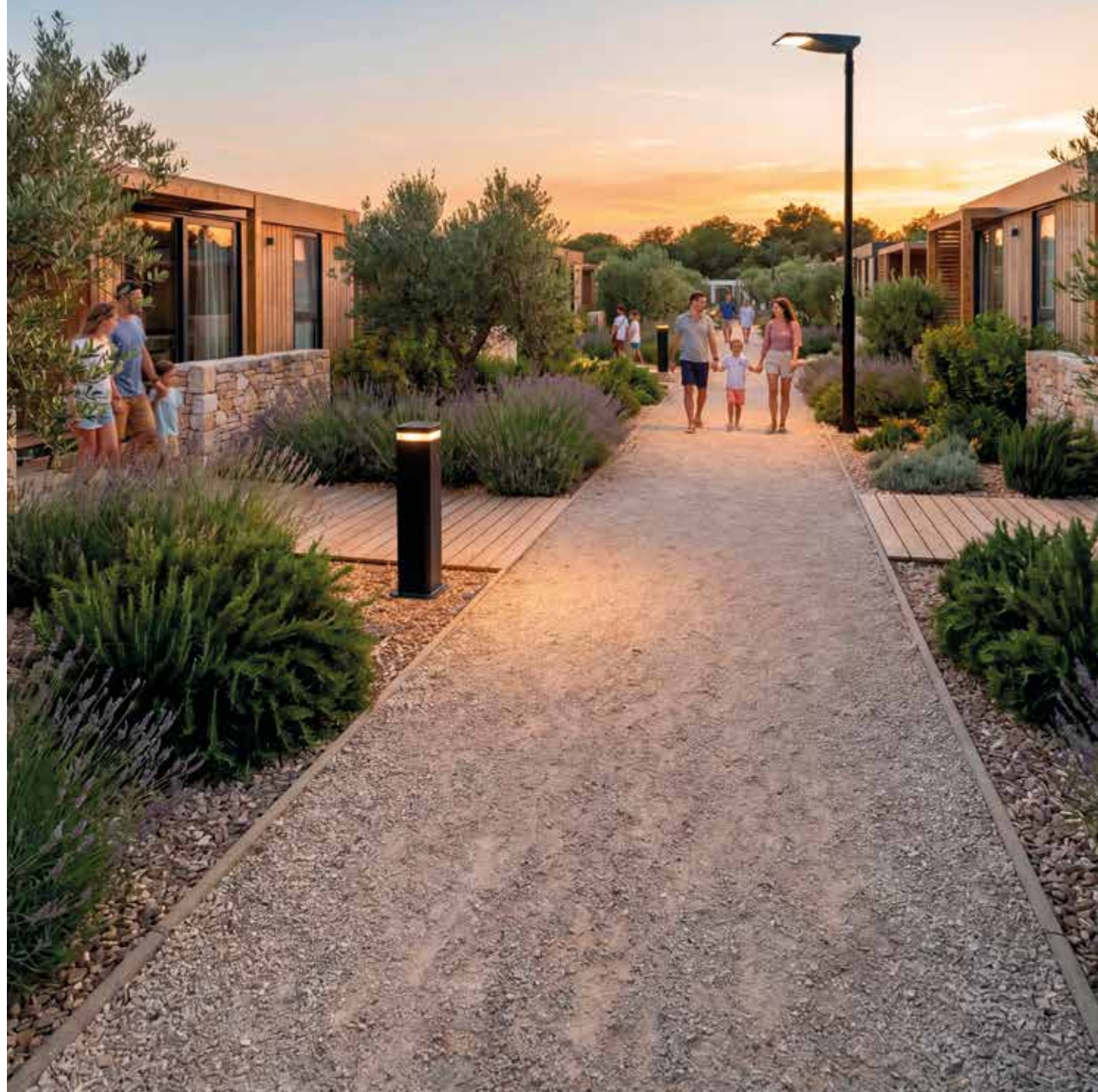
Luminaria MILAN S SOLAR en un camping
