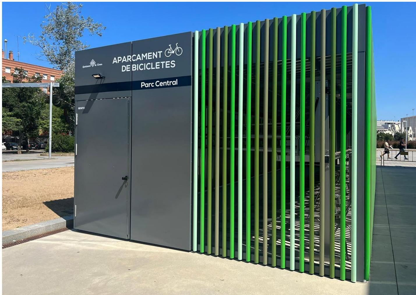
En el Parc Central de Girona, al lado de la estación del TAV, la estación de autobuses y cerca de la estación de tren de Renfe se ha instalado un aparcamiento con capacidad para 70 bicicletas. Se ha fabricado con una estructura metálica a base de perfiles laminados de colores y está pensado para ser flexible y pueda ampliarse o reducirse, o trasladarse a otra ubicación si hace falta en el futuro.
