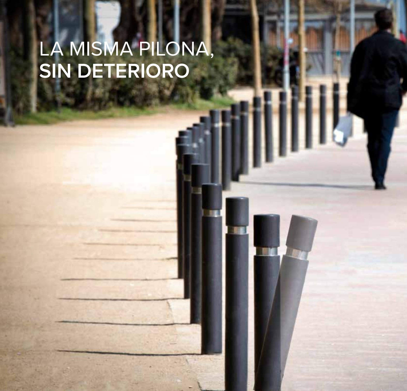
Instalación pilona DURABLE , en Barcelona.
