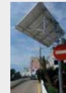
Kit de alimentación con baterías, para pilonas automáticas, que se cargan por la noche aprovechando la instalación del alumbrado público.
